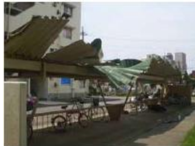
ガソリンスタンドの折板屋根の脱落 駐車場の折板屋根の著しい変形
