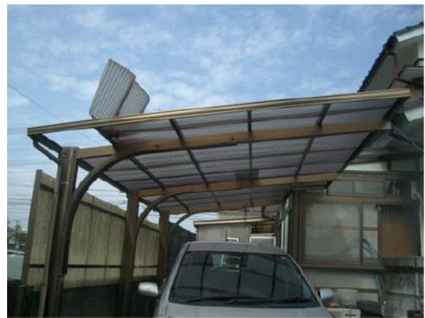
カーポート屋根の損傷
