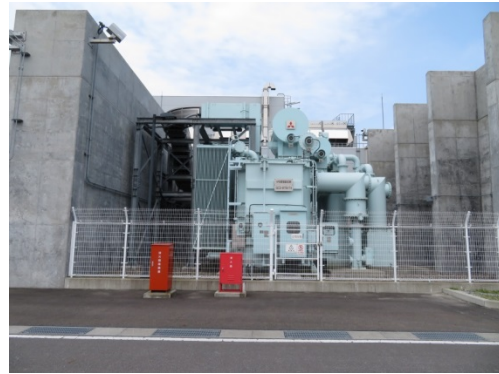
4号受電変圧器
