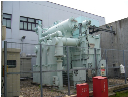
1号受電変圧器
