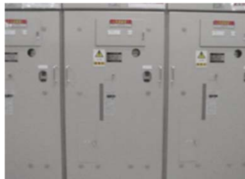
第8図 ガス遮断器
