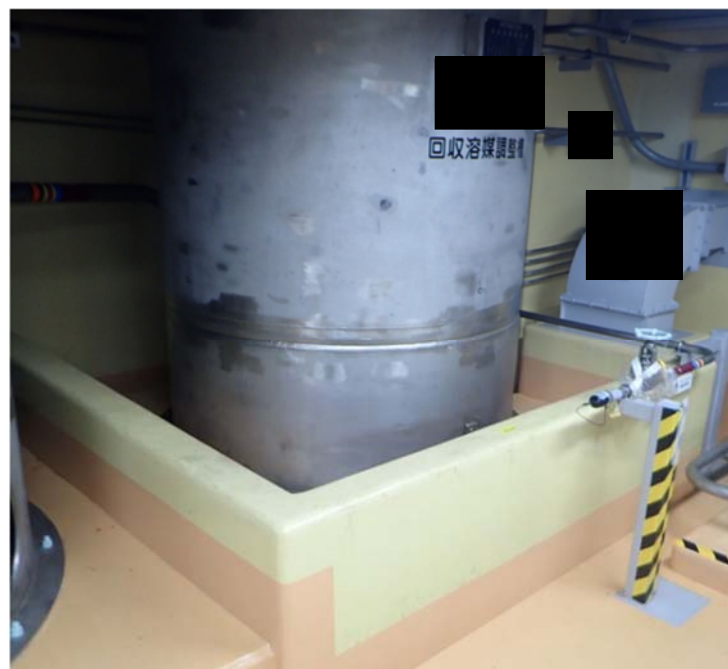
第2図 堰による拡大防止対策例
