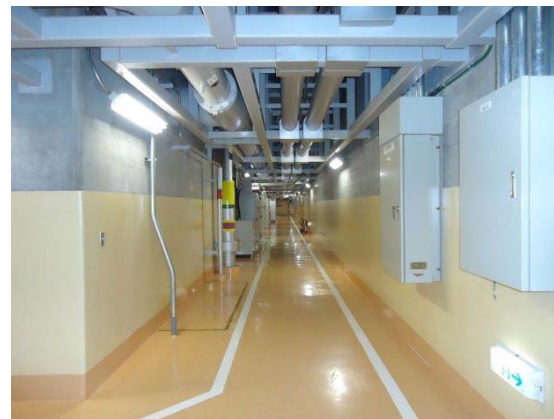
高レベル廃液ガラス固化建屋 地下1階東西第2廊下, 南北第1廊 下, 南北第2廊下
