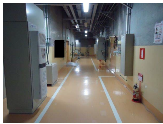
高レベル廃液ガラス固化建屋 地下4階東西第1廊下, 東西第3廊 下, 南北第1廊下, 南北第2廊下
