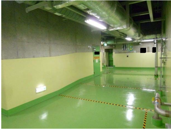
高レベル廃液ガラス固化建屋 地上1階東西第3廊下, 南北第2廊下, 南北第3廊下
