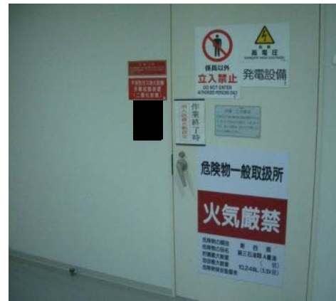
CO 2 設置室入口
