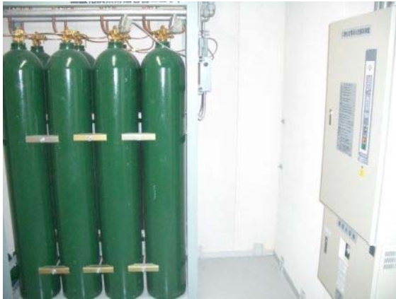
CO 2 ボンベ設置状況
