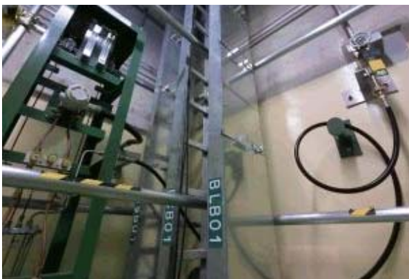
分離建屋 安全系ケーブルトレイ (B) (A系は遠方にあります)
