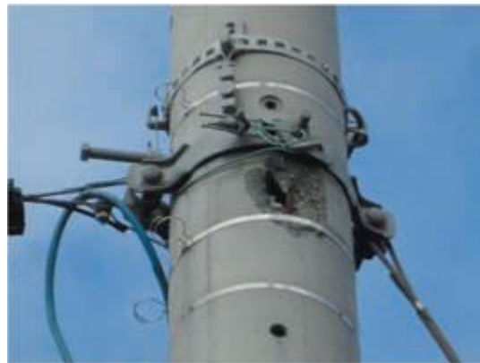
図4-4-1 コンクリートの剥離事例 (1)
