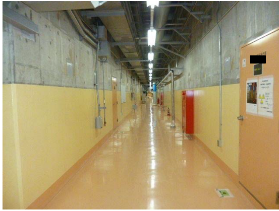
使用済燃料受入れ・貯蔵建屋 地下2階南北第3廊下
