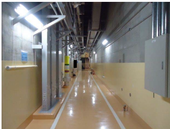
高レベル廃液ガラス固化建屋 地下2階南北第1廊下, 地下3階東 西第3廊下, 南北第1廊下, 南北第2 廊下
