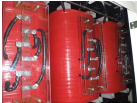
第5図 乾式変圧器
