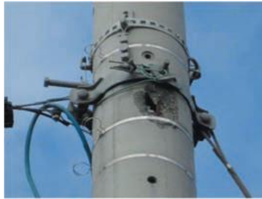
図4-4-1 コンクリートの剥離事例 (1)
