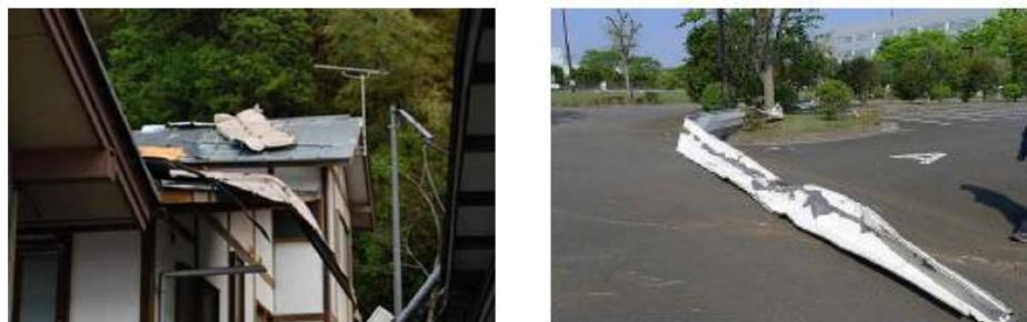
飛来物（鋼板製屋根材）の衝突 飛散した飛来物（鋼板製屋根材）
