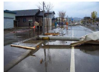
道路側へ倒壊した電柱
