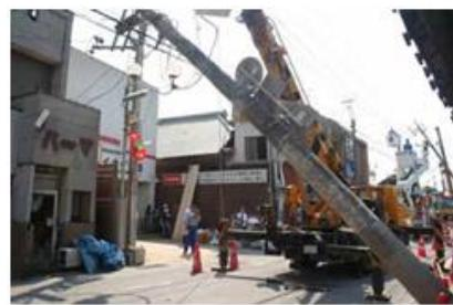
倒れた電柱（復旧作業時）
