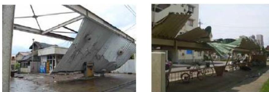
ガソリンスタンドの折板屋根の脱落 駐車場の折板屋根の著しい変形
