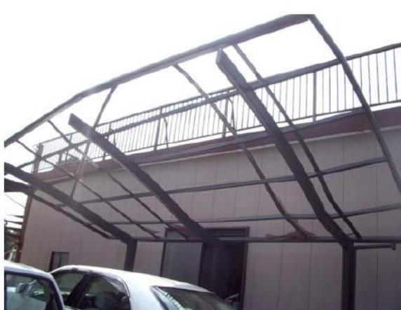
カーポート屋根の飛散及び骨組の損傷
