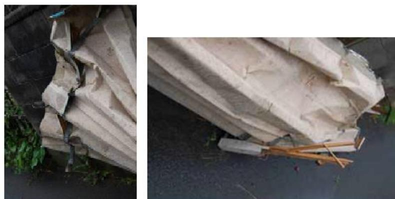
飛散した折板屋根の損傷状況
