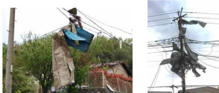
電線等に引っ掛けた飛来物（鋼板製屋根材）
