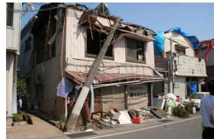
倒壊電柱に直撃された家屋
