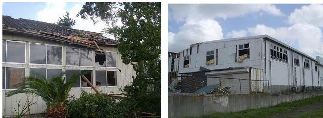
倉庫の窓ガラスと屋根の被害状況
