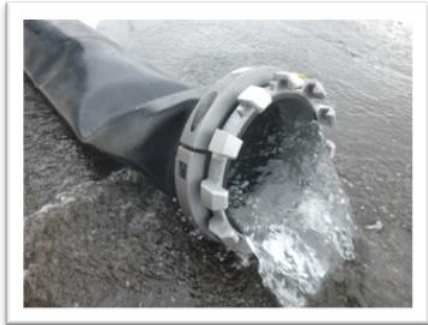
建屋外ホース接続箇所 (300A)
