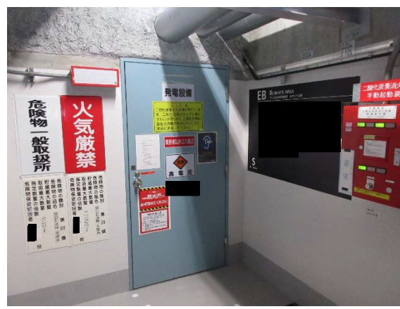
CO 2 設置室入口
