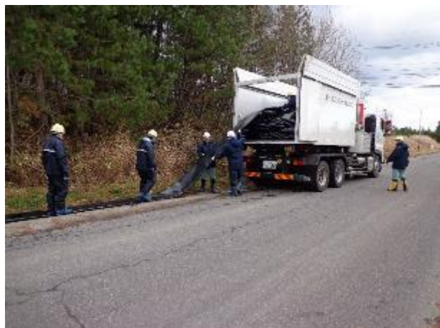
建屋外ホースの敷設
