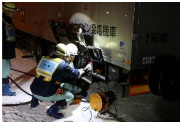
電源車へのケーブルの繋ぎこみ
