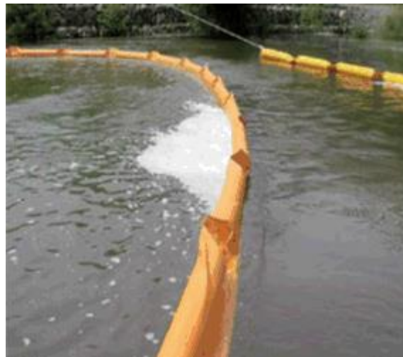
可搬型汚濁水拡散防止フェンス
