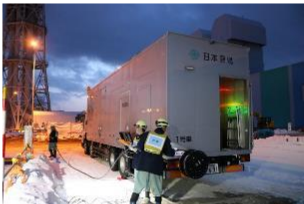
電源車から建屋にケーブルを敷設
