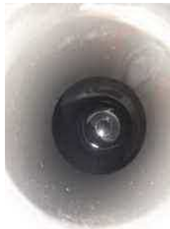
②出口配管
