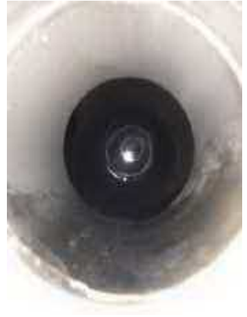
②出口配管
