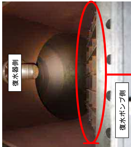
3C-復水ポンプ入口ストレーナ
