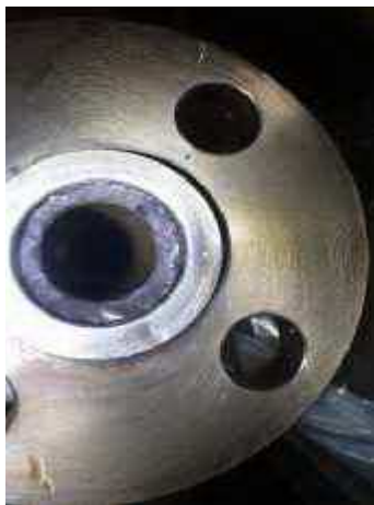
①入口配管
