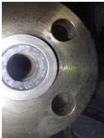
①入口配管
