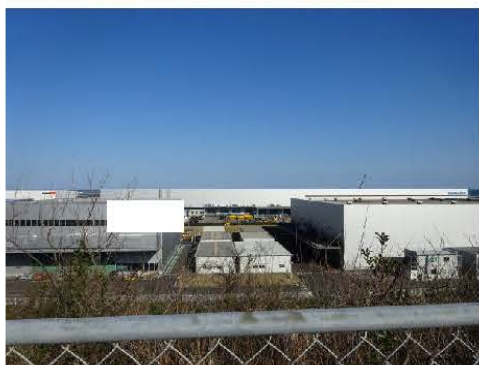
1 : 鉄筋コンクリート造
