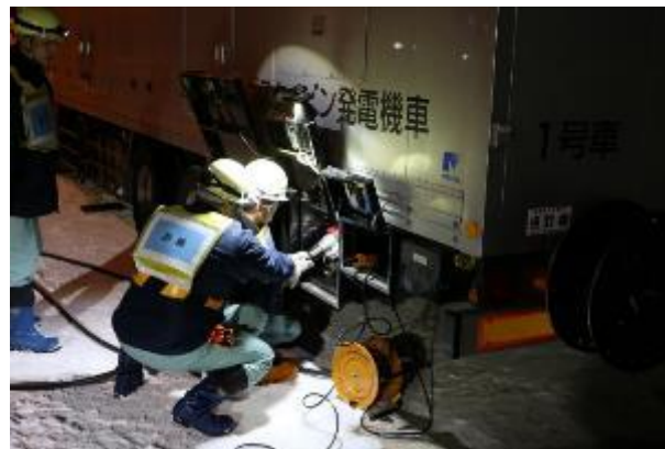
電源車へのケーブルの繋ぎこみ
