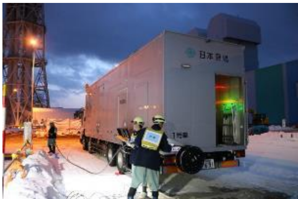
電源車から建屋にケーブルを敷設
