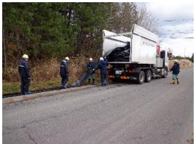
建屋外ホースの敷設
