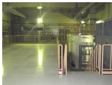
RCW サージタンク及び 計器ラック
