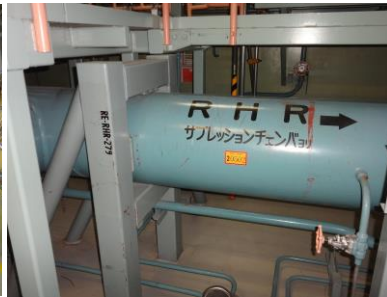
配管及び支持構造
