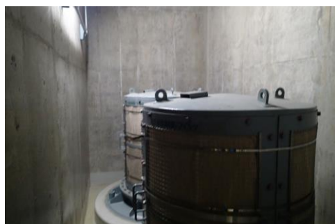
A-給気消音器フィルタ
