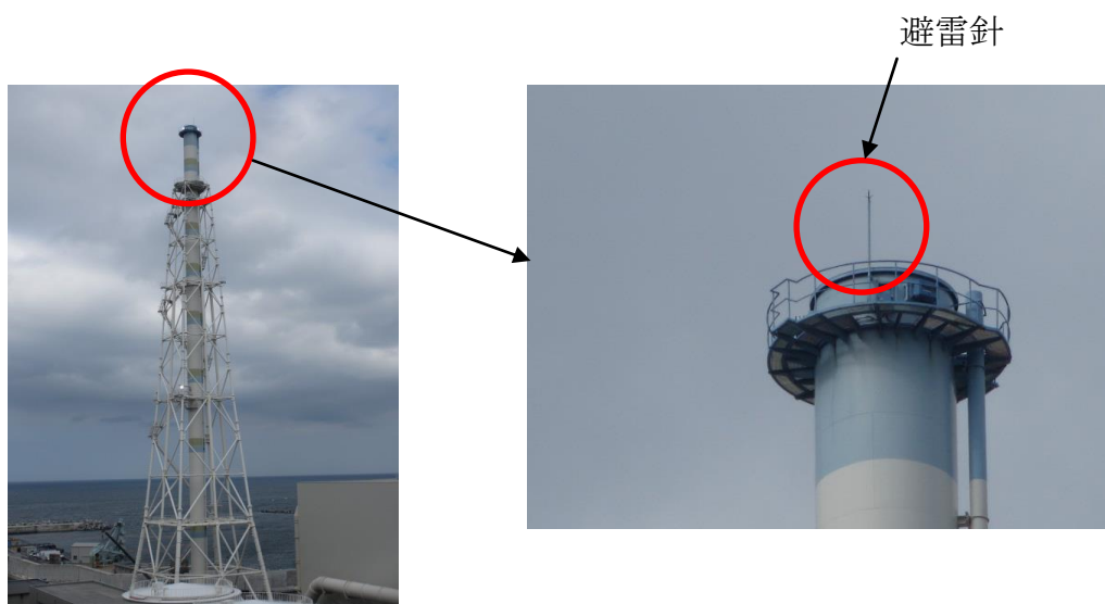
第41-1-12図 避雷設備の設置例 (排気筒)
