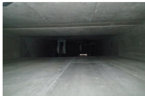
B-給気消音器フィルタ室内
