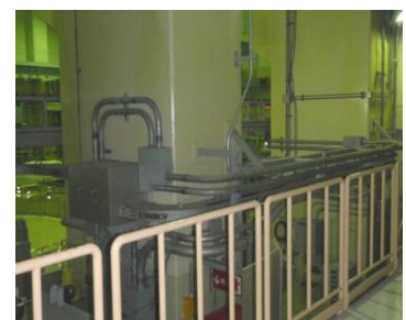
電線管及び端子箱
