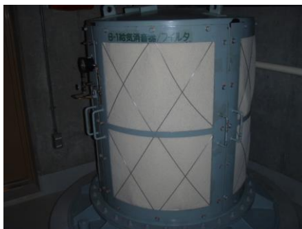
B-給気消音器フィルタ
