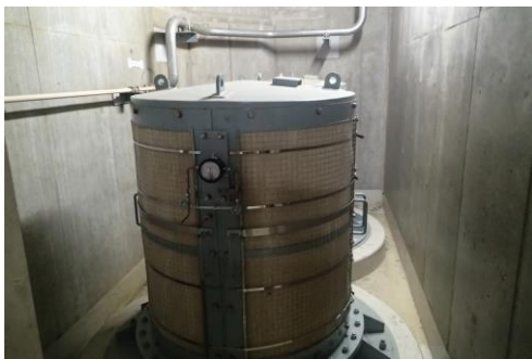
H P C S 給気消音器フィルタ
