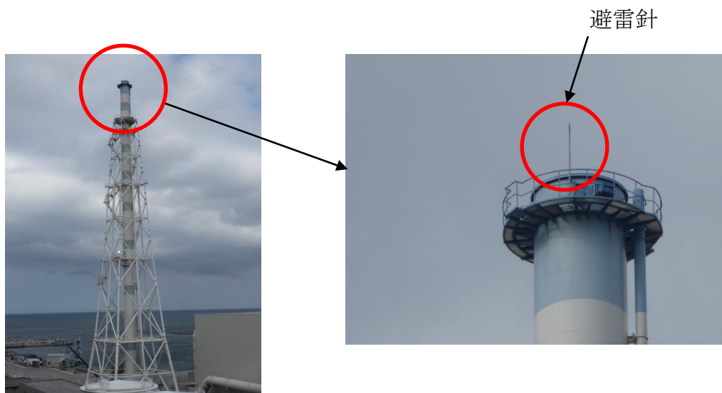
第1-15図 避雷設備の設置例（排気筒）
