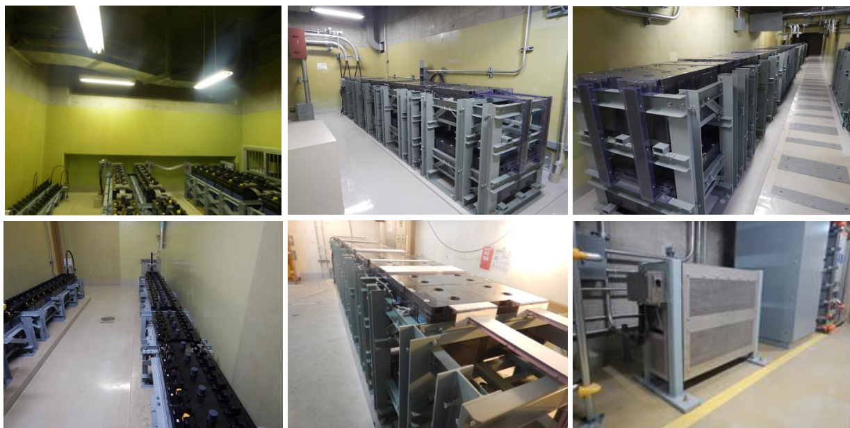
第1-39図 蓄電池の設置状況 (1 / 7)
