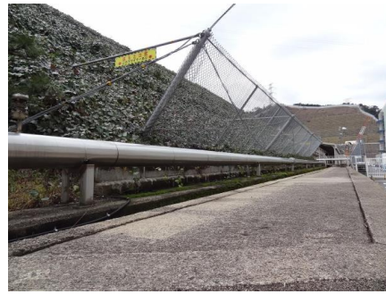
第 1 -32 図 屋外消火配管への保温材の設置状況
