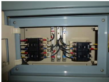
気中遮断器の例 (ブレーカ)
