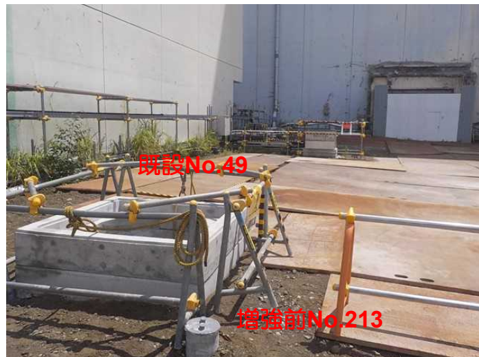
No.49ピット周辺
