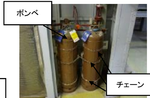
美浜発電所 別館横ラック アセチレン (分析用)
