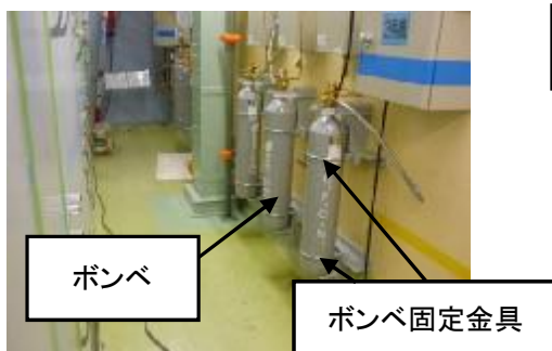
美浜3号機 中間建屋 ハロン 1301 (消火設備)
