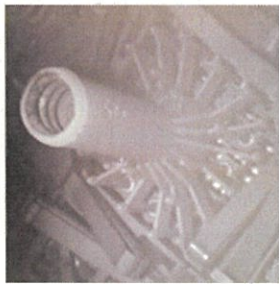
【原子炉格納容器内】
