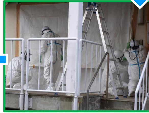
破損した扉を養生する工務班員
