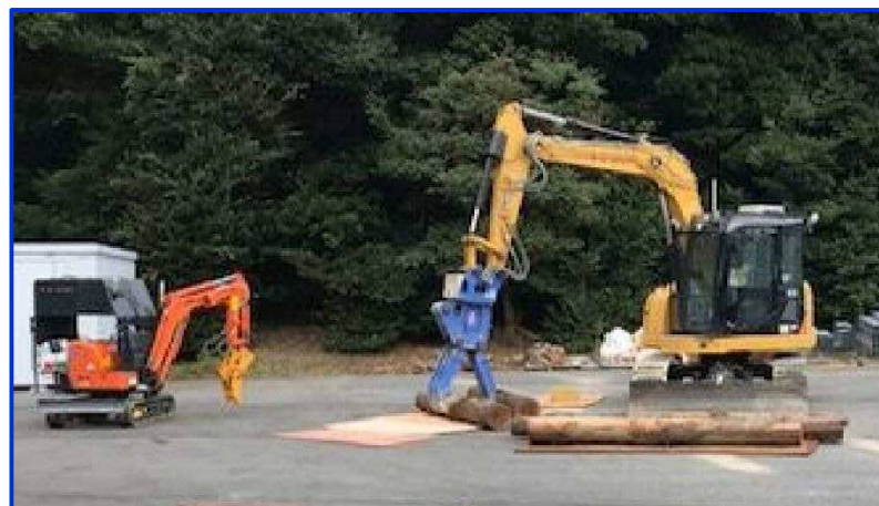
無線重機による丸太撤去（ルート確保）
