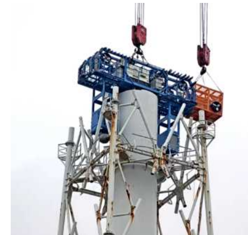
搭乗設備 作業状況
