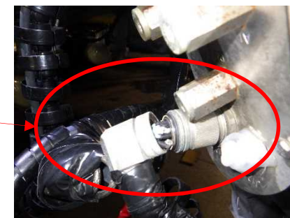
養生ビニルテープをはがした状態
