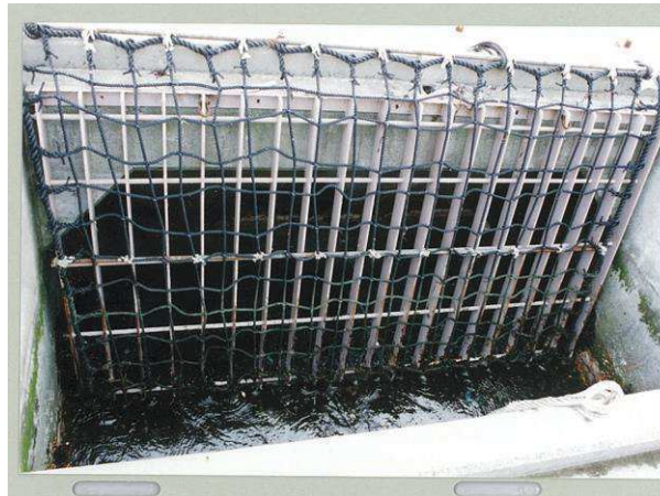
写真1 1号炉取水口固定式バースクリーン
