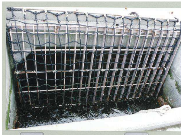
写真1 1号炉取水口固定式バースクリーン
