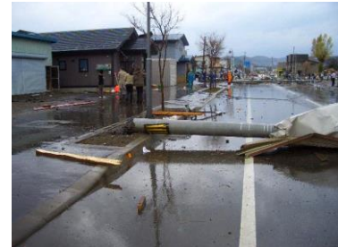
道路側へ倒壊した電柱
