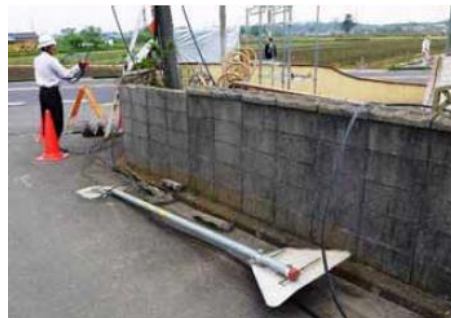
道路標識の倒壊
