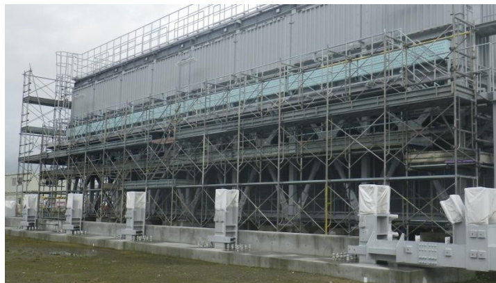
第 33 図 敷地内における仮設足場の状況
