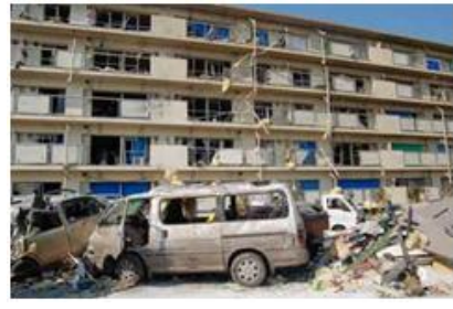
飛来物により被害を受けた住宅等
