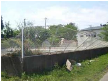
フェンスの変形
