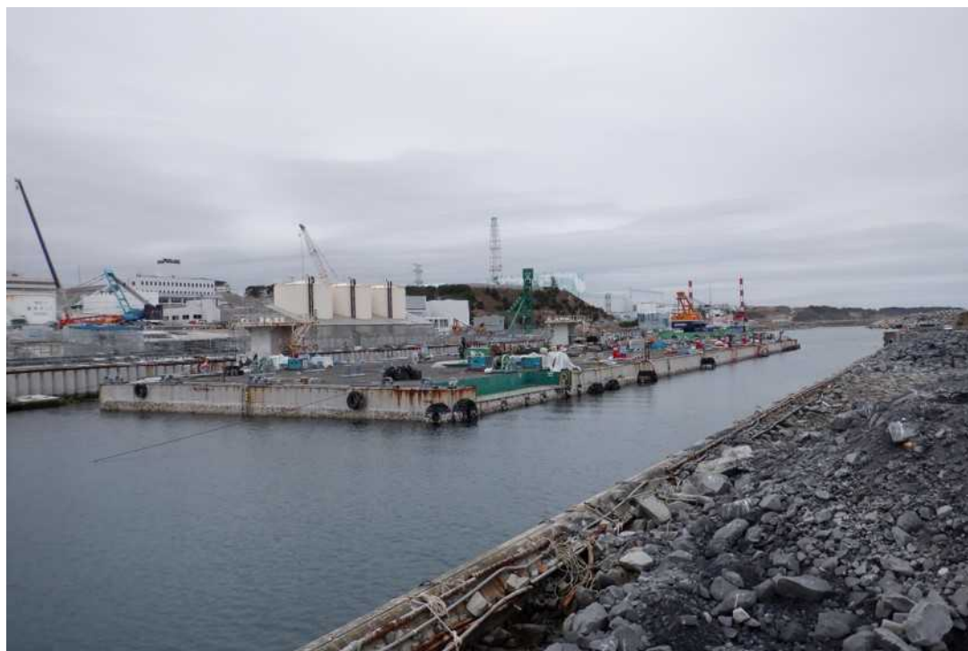
【仮着底後のメガフロートの様子】
