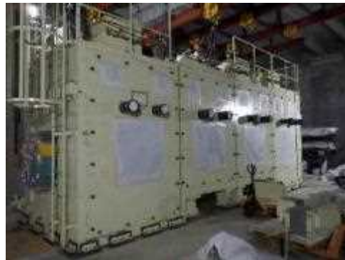
鉄セル本体据付作業状況の例
