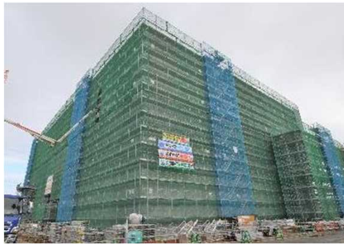
建屋工事全景写真
