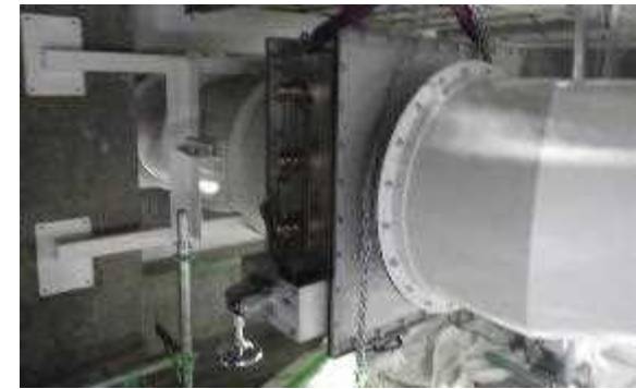
換気・空調設備の工事状況の例
