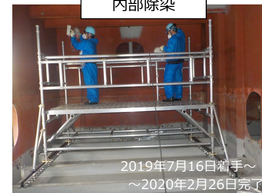
写真⑤: メガフロート内部での除染状況
