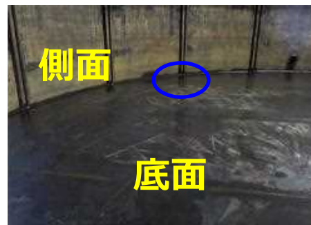
【参考】同型タンク内面写真（水抜き後）
