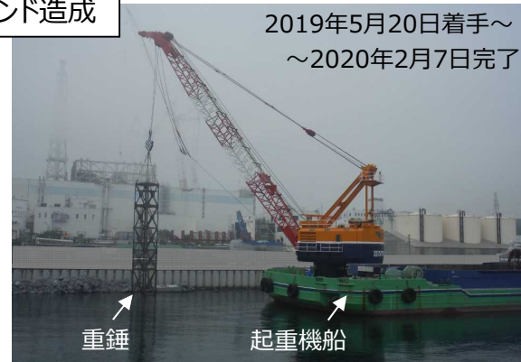
写真③: 起重機船による着底マウンド均し状況
