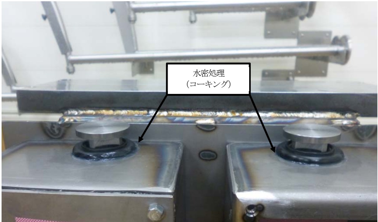
第1図 水密処理の例 (イメージ)
