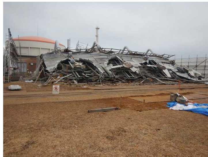
写真⑥ 撤去中状況(西側) (令和元年12月11日撮影)
