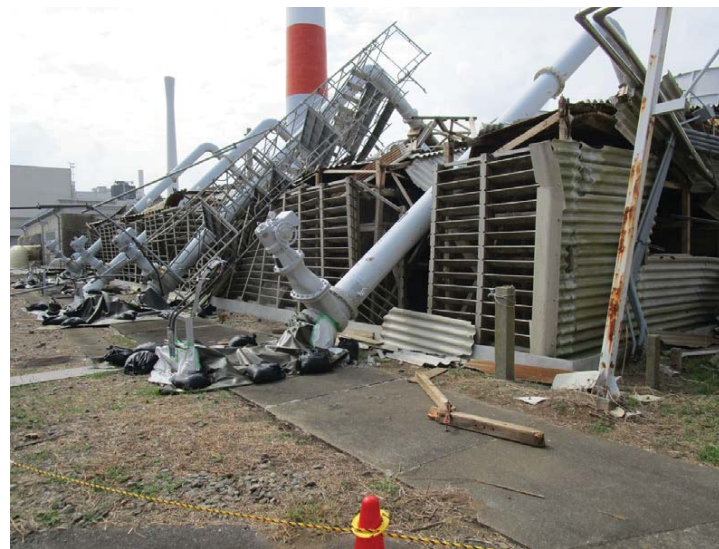
写真③ 撤去前状況(東側) (令和元年10月3日撮影)
