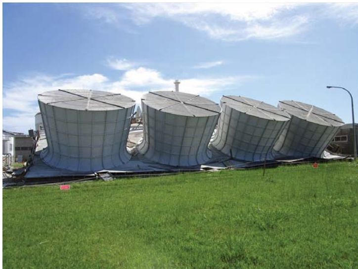
写真⑤ 撤去前状況(西側) (令和元年9月12日撮影)
