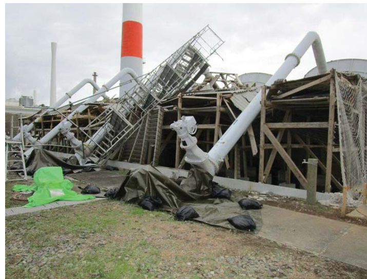
写真④ 撤去中状況(東側) (令和元年10月24日撮影)
