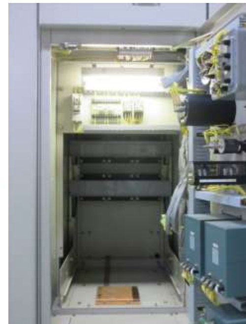
高圧しゃ断器の撤去後の状況
