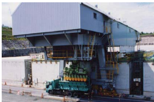
第1図 廃棄物埋設地における埋設クレーンによる吊上げ
