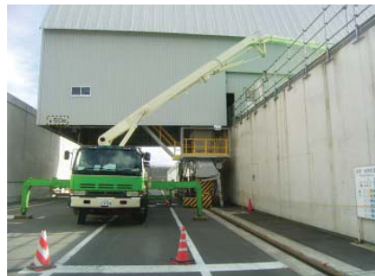
第4図 埋設設備内への充填材充填
