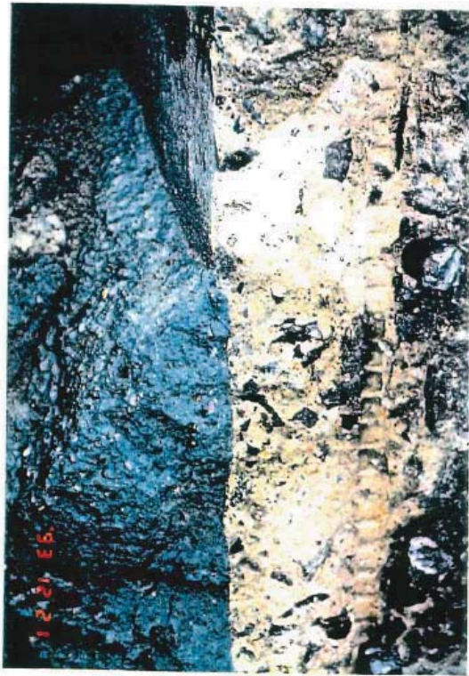
第 13 図 セメント系充填材部分の解体状況(側壁コンクリートとの境界部の状況)
