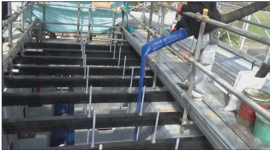
第 25 図 充填モルタル打込み状況
