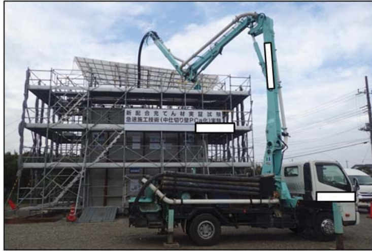
第 23 図 モルタル打設方法
