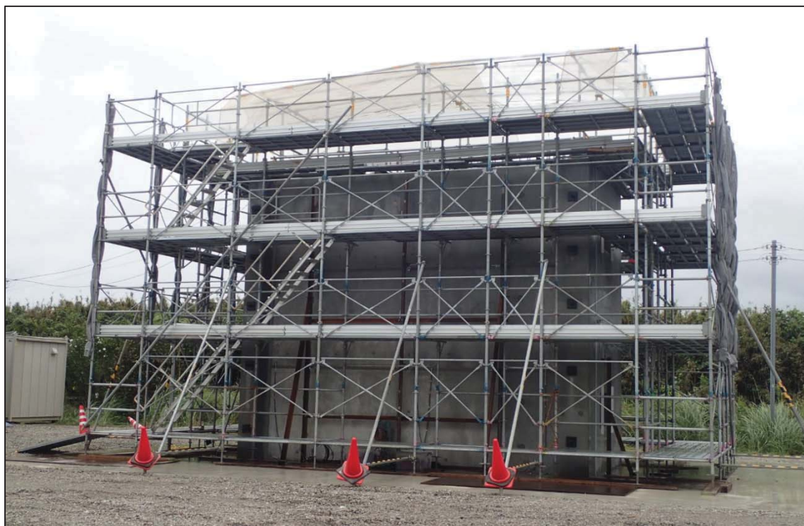
第 21 図 実証試験供試体の外観
