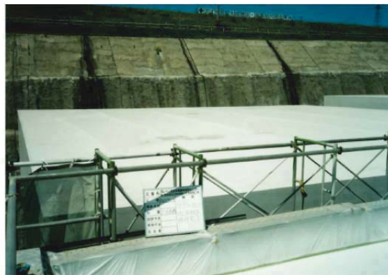
仕上げ材吹付け
