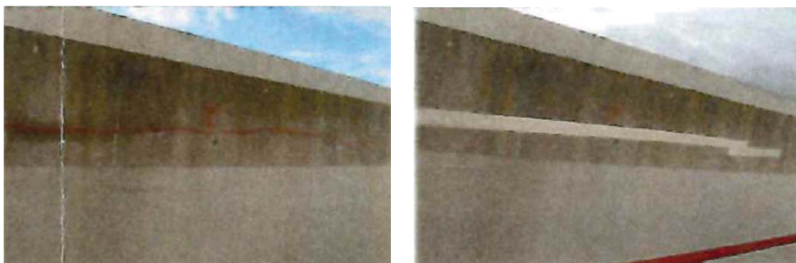
写真 9 表面止水工(1 号 4-C 覆い側部)
