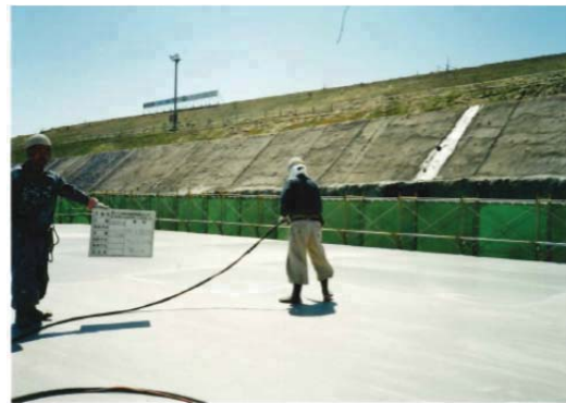
防水材吹付け
