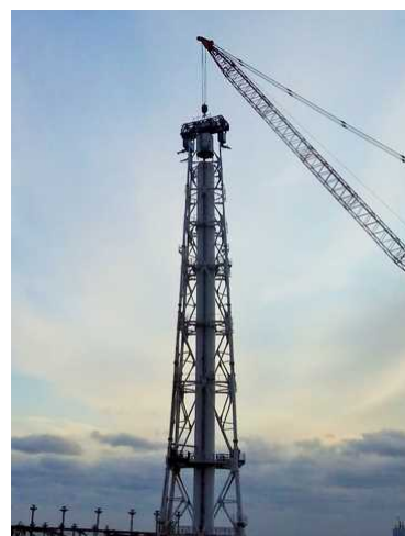
5ブロック解体後 (2019年12月19日)
