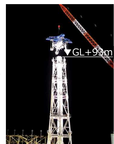
11ブロック解体後 (2020年2月1日)
