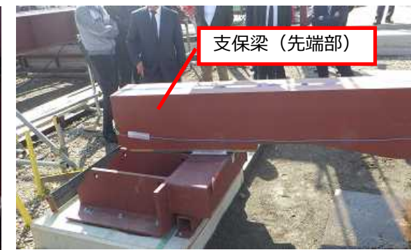
③支保梁挿入（完了）
