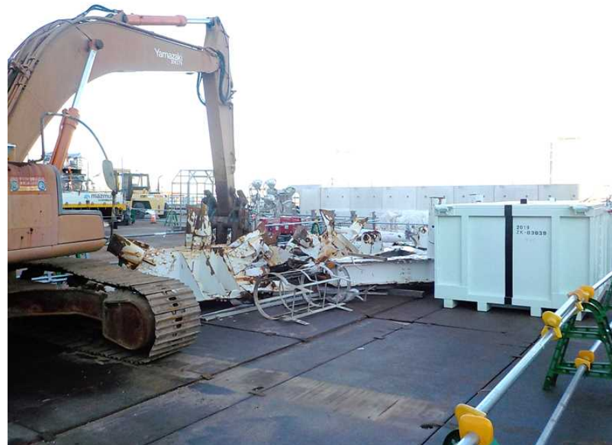
【写真②】鉄塔の小割状況 (小割ヤード：8.5m盤)
