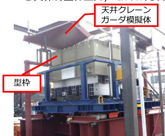
④支保材型枠上昇，モルタル充填
