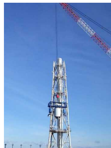
9ブロック解体後 (2020年1月11日)
