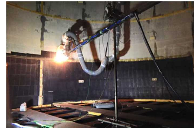
タンク内部でのレーザー除染の実施状況
