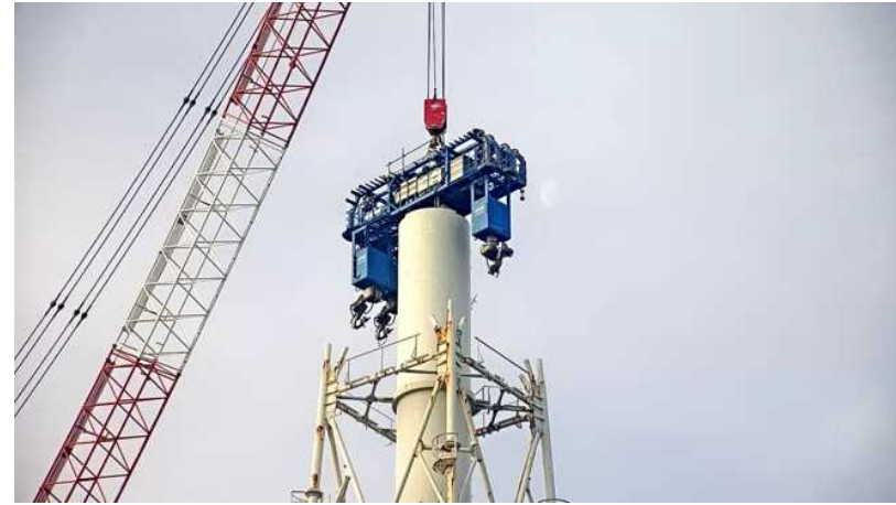
9ブロック目筒身解体作業(1月16日)
