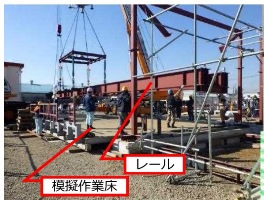
①レール吊り込み
