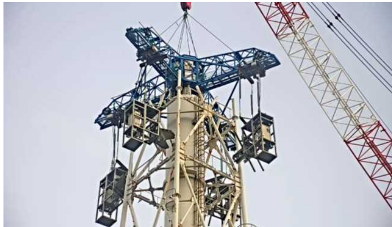
8ブロック目鉄塔解体作業(1月15日)
