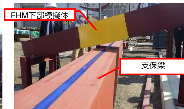
②支保梁挿入
