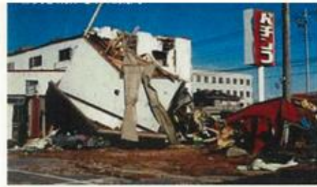
吹き飛ばされた建物
