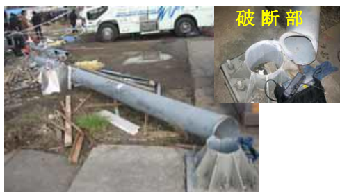
倒壊した道路標識支柱
