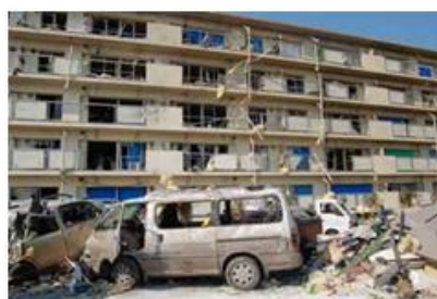
飛来物により被害を受けた住宅等
