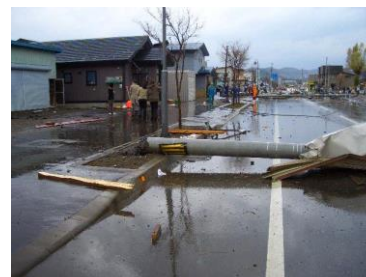
道路側へ倒壊した電柱
