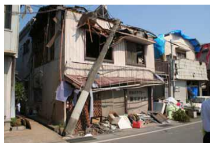
倒壊電柱に直撃された家屋
