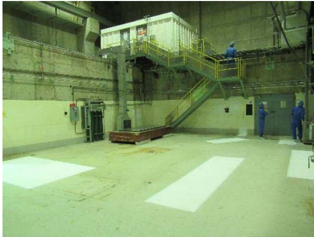
タービン建屋 1階 機械工作室
