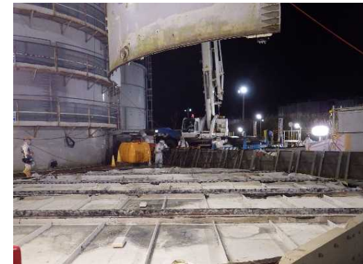
【1段目撤去状況】 1段目・底板を撤去
