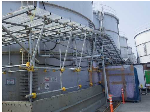
【チェンジングプレート設置状況※1】 1段目マンホールより内部へ浸入
