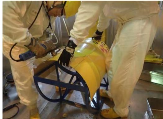
図6.ドラム缶の切断作業
