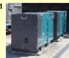
移動式発電機 (1000kVA) ※1
