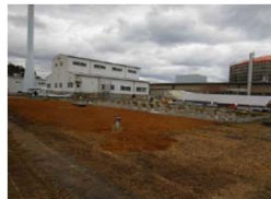
倒壊した二次冷却塔の撤去状況
