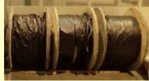
安全系負荷への予備ケーブルの配備 ※2
