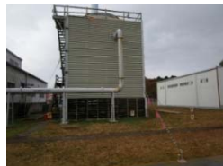
UCL系統冷却塔の固定の状況
