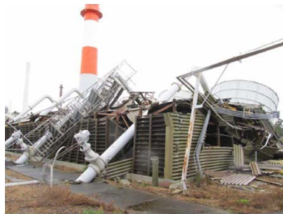
二次冷却塔倒壊時の状況
