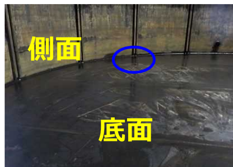
【参考】同型タンク内面写真（水抜き後）
