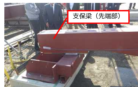
③支保梁挿入（完了）
