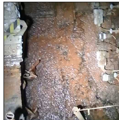
← 4号機廃棄物処理建屋 地下1階の床面露出状況
