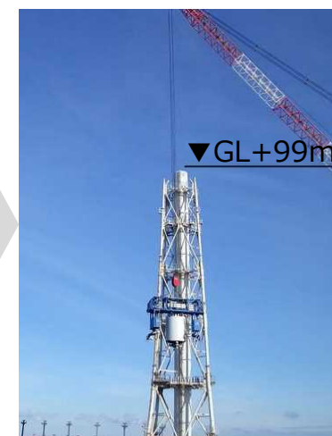
9ブロック解体後 (2020年1月17日)
