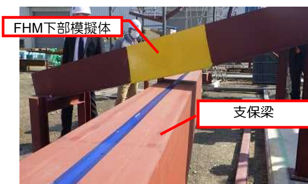
②支保梁挿入
