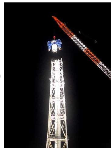
7ブロック解体後 (2020年1月11日)
