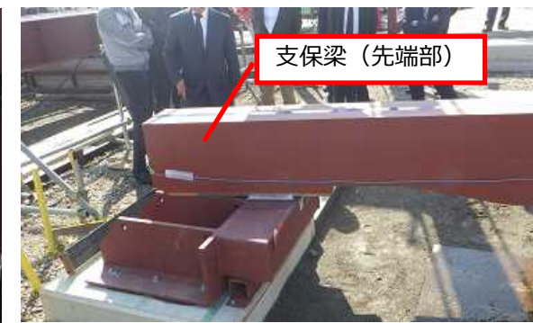
③支保梁挿入（完了）
