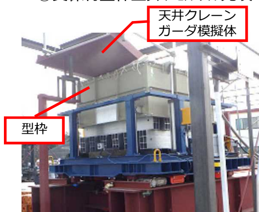
④支保材型枠上昇、モルタル充填
