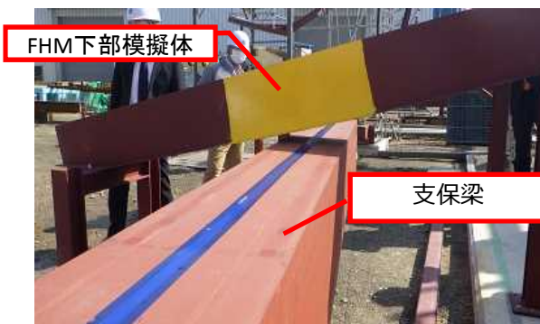
②支保梁挿入
