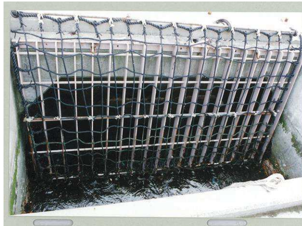
写真1 1号炉取水口固定式バースクリーン
