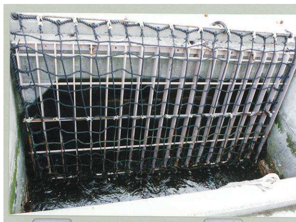
写真1 1号炉取水口固定式バースクリーン
