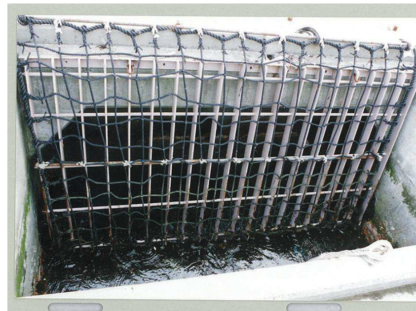
1号炉取水口固定式バースクリーン
