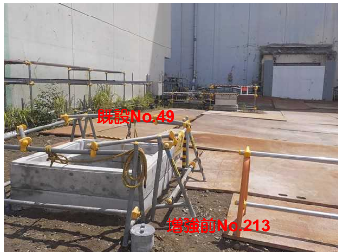
No.49ピット周辺
