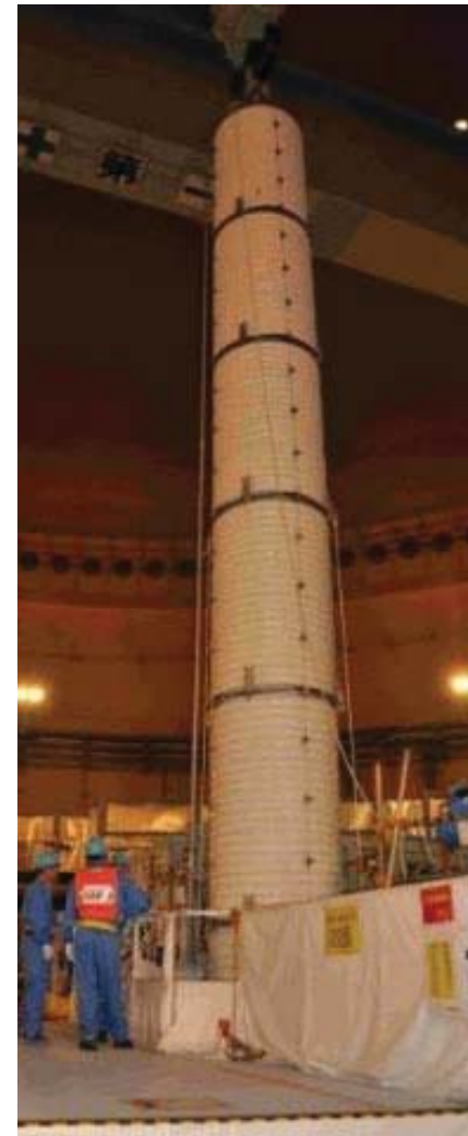
簡易キャスクによる燃料出入孔スリーブ、炉内中継装置を一体で引抜き
