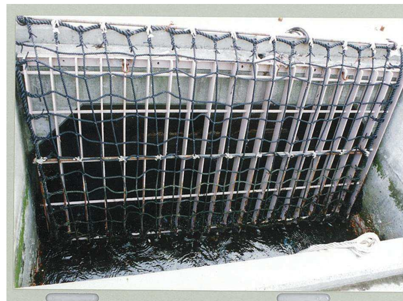
1号炉取水口固定式バースクリーン
