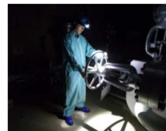
暗闇での 弁操作訓練
