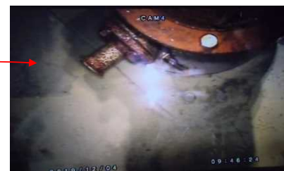
モルタル硬化の様子 (12/4)
