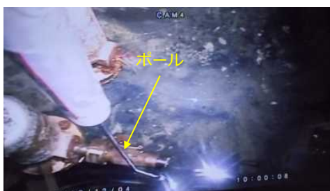
操作ポール挿入前 (12/4)
