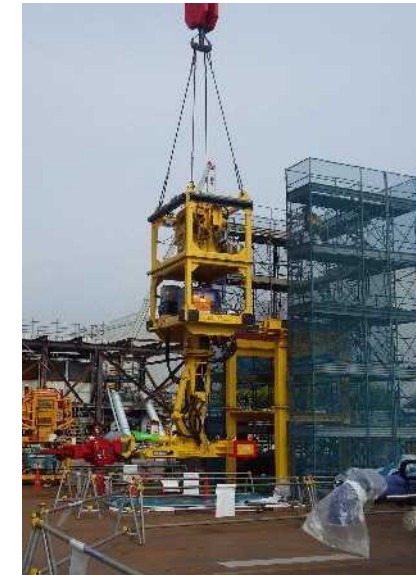
クレーン吊り状況（全景）
