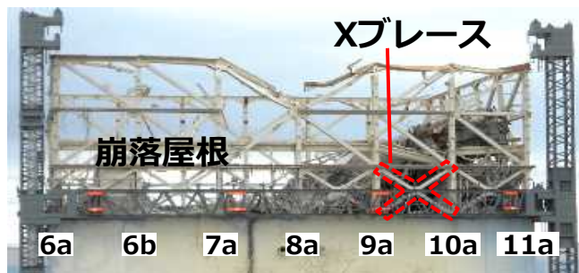
オペフロ外周鉄骨 (西面)
