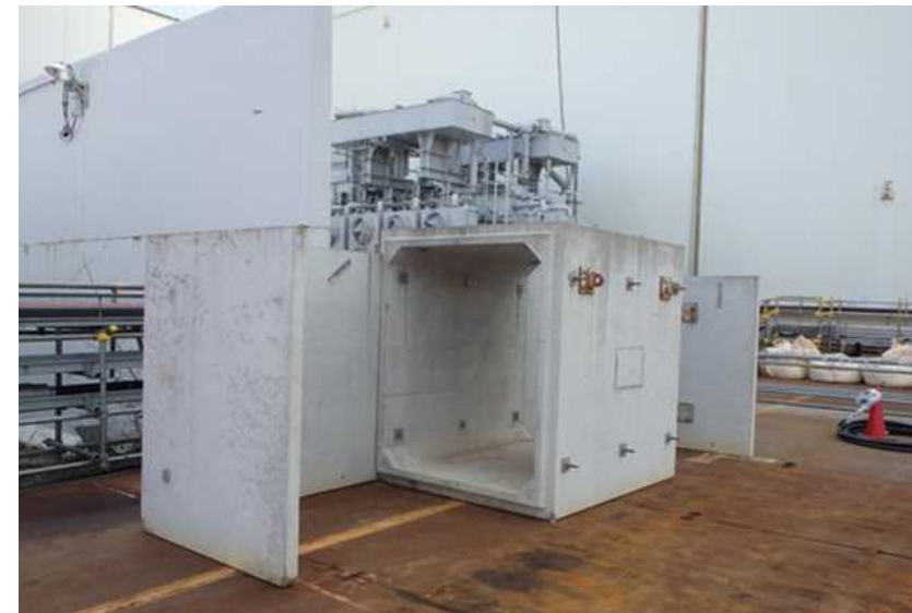
ボックスカルバート設置状況
