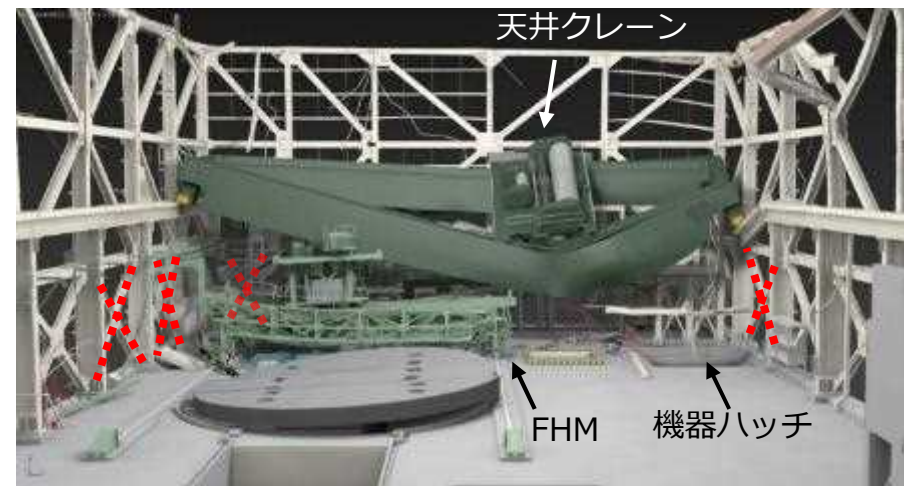
A方向から見たイメージ (オペフロ南側崩落屋根を除いた天井クレーン、FHMイメージ)
